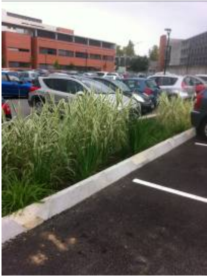
Photo 1 : bordure et poutre béton en tête de noue
